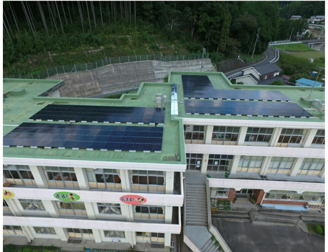
写真：新城市鳳来中部小学校の太陽光発電パネル
